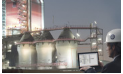
Der neue Hochofen 8 in Duisburg: ausgestattet mit modernster Umwelttechnik.
